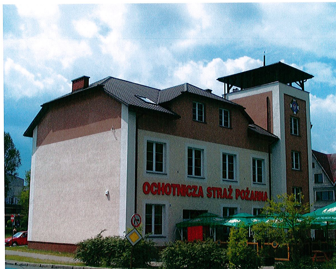
Budynek Ochotniczej Straży Pożarnej w Ostrołęce Ostrołęka, ulica Głowackiego 44 po modernizacji i rozbudowie 2002 -2004 [widok od strony północno – wschodniej] 20 czerwca 2004r.
